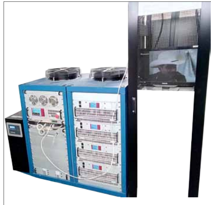
Transmisor Digital de 1,7 kW RMS y unidad receptora del STL instalados en Cerro la Virgen, Zactecas (México)
