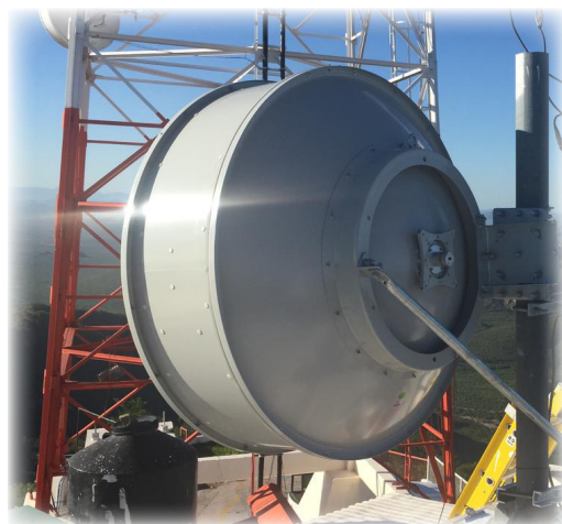
Instalación de la antena del receptor
