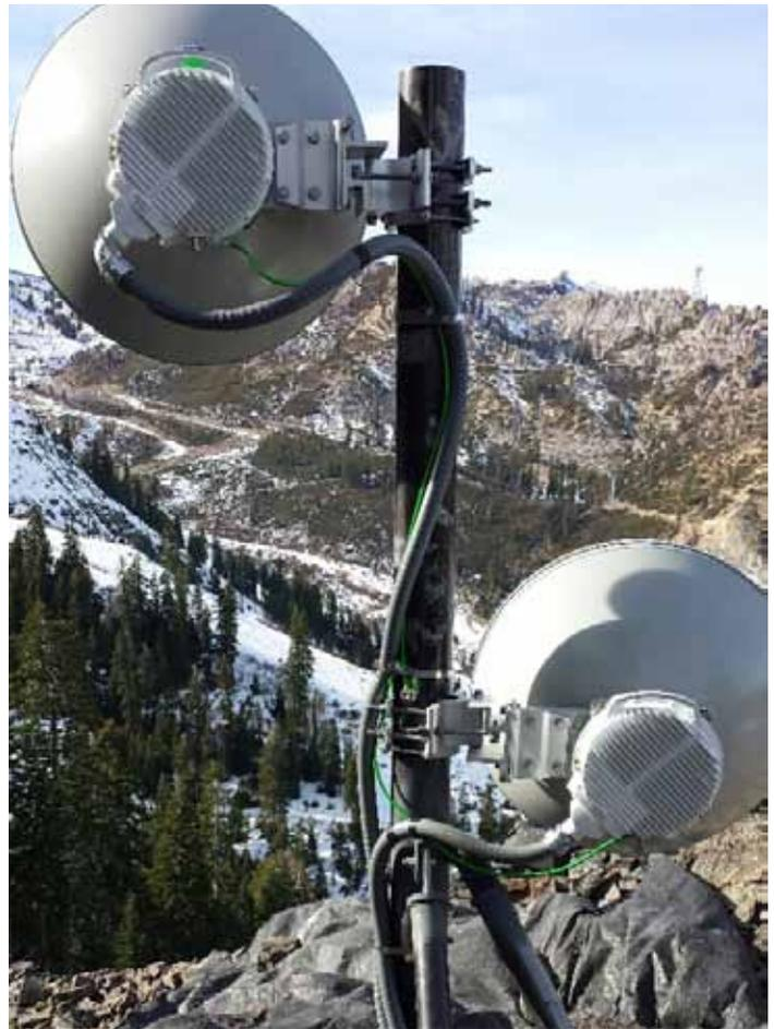
Usando la banda libre de 24GHz, Cable AML, con la ayuda de Cable Master, suministró e instaló tres IPLINKS para conectar la parte alta de la montaña al edificio principal. El proyecto en su totalidad se completó en siete días.
