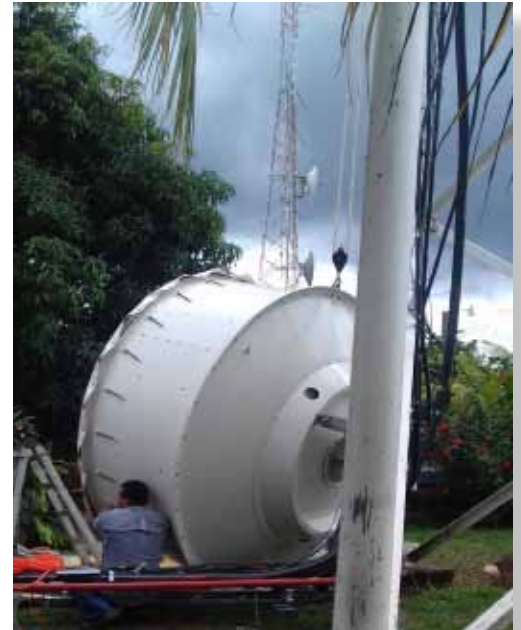
Instalación de la antena de 2,4 metros
