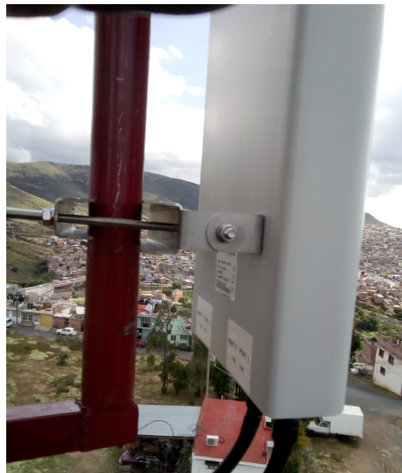
Antena sectorial con vista del área de cobertura
