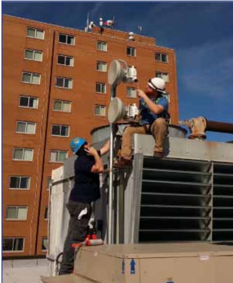
Equipo de Instalación Probando la Capacidad del Enlace.
