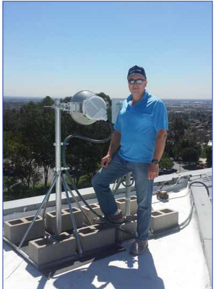
Ingeniero de Cable AML Supervisando la Instalación del enlace.
