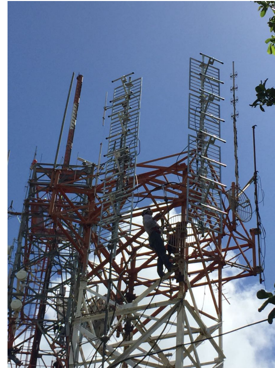
Personal de ABS instalando antenas
