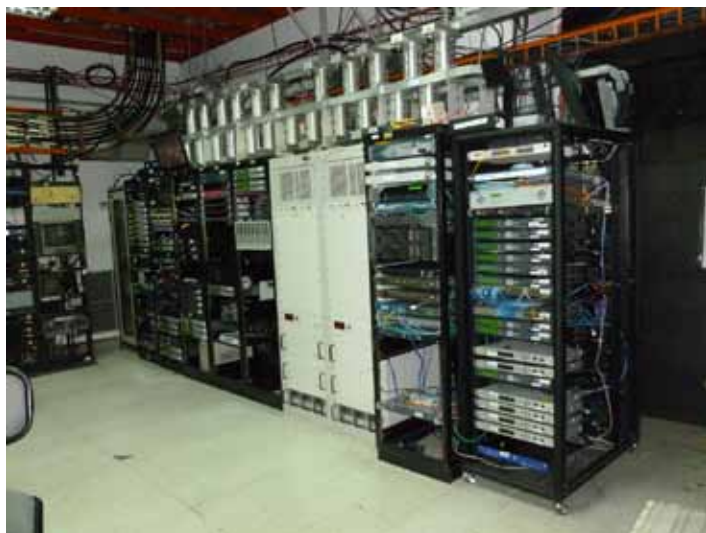
Transmisores de banda ancha y de alta potencia de Cable AML transmiten televisión digital e Internet inalámbrico simultáneamente.
