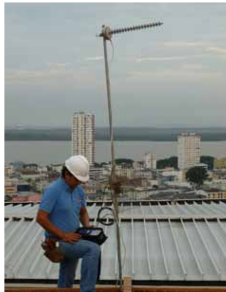
Técnico de Univisa instala antenas de suscriptores para el servicio de Internet inalámbrico.
