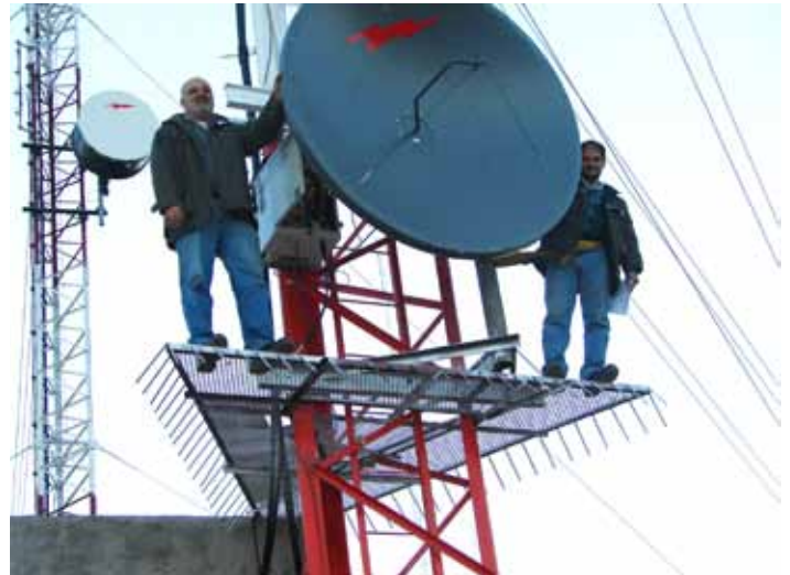
Ing. Juan Ise, Gerente de Ingeniería y Martin Marcinkiewicz, Ingeniero de Aplicaciones, verificando la instalación de las nuevas antenas.
